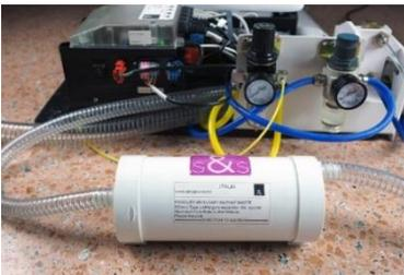
Separador de amalgama DDS2011 instalado en una unidad dental. El dispositivo se coloca en el piso al lado de la unidad dental y se puede colocar dentro de la cubierta del piso, si el espacio lo permite. El separador en la imagen, se instala al lado de la unidad, pero se puede colocar en la posición que se considere más apropiada.
