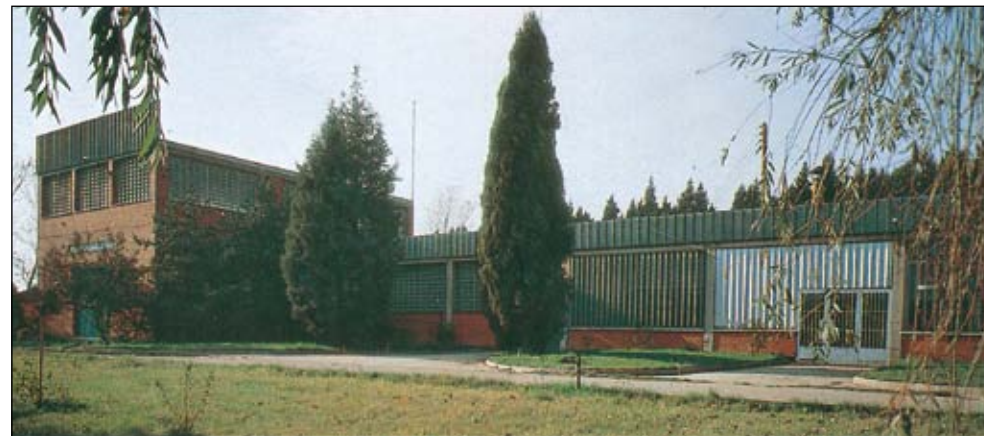
Planta de esterilización
